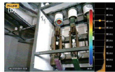
(a)電機定子的檢查 (b)機櫃和匯流排的檢查
